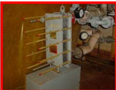
91823 Alfa Laval, 60 pies 2 , Placas de Acero Inoxidable, 100 psi, 250°F
