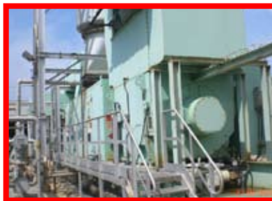
Kato, Generador Eléctrico 5.1 MW, 4.16 volts, 60Hz, construido en 1998, 31,000 horas de servicio conectado a una turbina de gas Alstom, capacidad máxima 6.0 MW.
