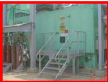
Kato, Generador Eléctrico 5.1 MW, 4.16 volts, 60Hz, construido en 1998, 31,000 horas de servicio conectado a una turbina de gas Alstom, capacidad máxima 6.0 MW.
