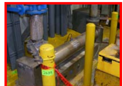
92270 Aquafine, CSL 12R/60, Tipo purificador de luz ultravioleta, capacidad para 260 galones por minuto
