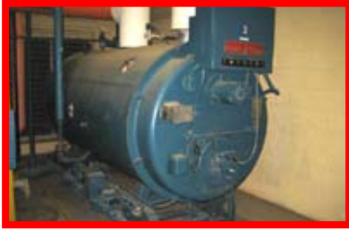
92818 Cleaver Brooks, CB-700-60 , 2000 lbs/hr, Gas Natural, 60 HP, 150 psi de Presión de vapor
